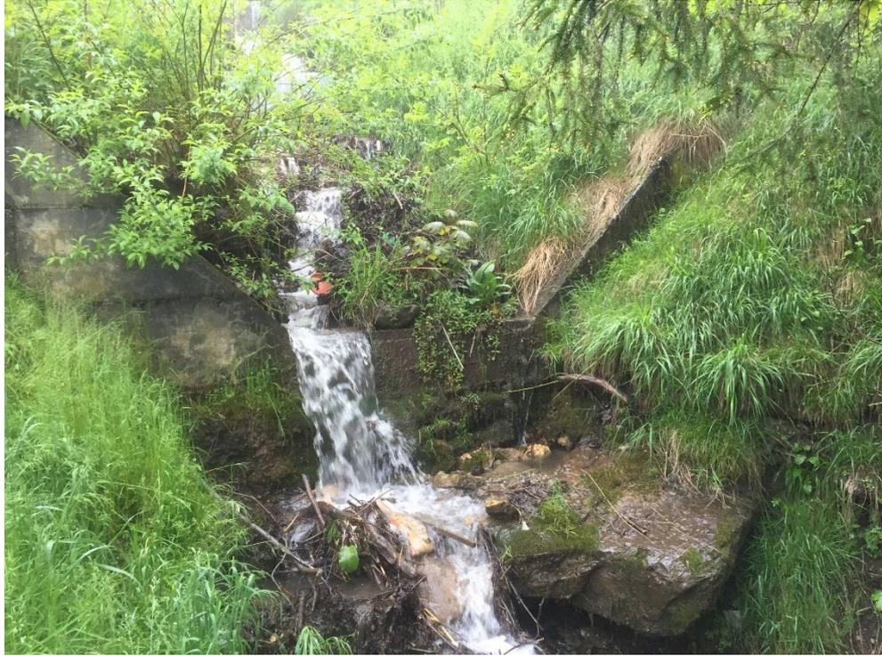
Abbildung 14: Foto Sperre in der Steilstrecke mit teilweise Erosion Unterstrom der Sperre -> Kolkbereiche sichern
