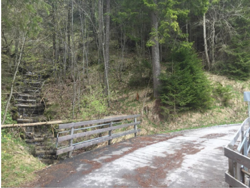
Abbildung 10: Ansicht linksufrige Böschung im Bereich neuer Geschiebesammler.
