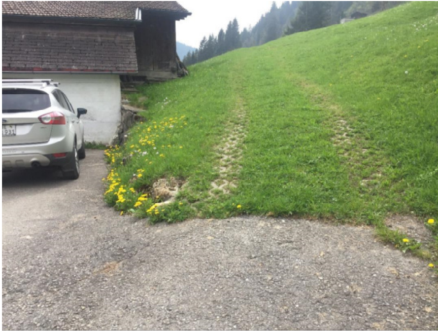
Abbildung 8: Zufahrt Abschnitt D über Parzelle 649. Auf den ersten Meter sind noch Rasengittersteine bestehend.
