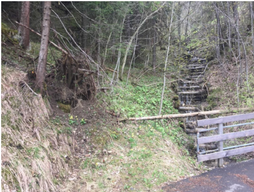
Abbildung 11: Ansicht rechtsufrige Böschung im Bereich neuer Geschiebesammler.
