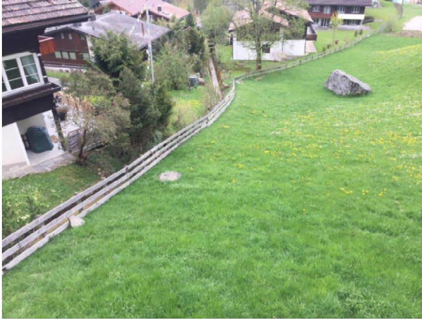
Abbildung 4: Ansicht Abschnitt C. Im Vordergrund ist die Fläche sichtbar welche flächig abgetragen wird für die Hochwasserschutzmassnahmen am Gerinne. Im Hintergrund der Bereich um die Gebäude welcher unnatürliche Böden tangiert.
