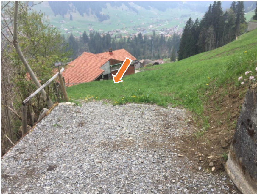
Abbildung 9: Abschnitt E, Bereich temporäre Zufahrt über die Parzelle 1925 für Bauteil 4 und angrenzende lokale Sohlensicherungen. Seitlich der Zufahrt wäre ein Bodenzwischenlager denkbar (Waldboden / Pfeil).
