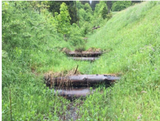
Abbildung 5: hinterspülter Holzsperrenausschnitt oberhalb Höhe Schrenziweg
