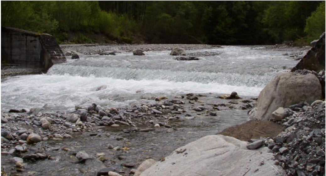
Abbildung 2: Schwelle bei der Rückgabestelle I de Stude. Eine Rückgabe des Geschiebes ist unterhalb der Schwelle möglich.
