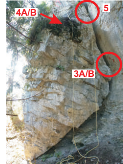
Foto: Übersicht Messstellen 3, 4 + 5
