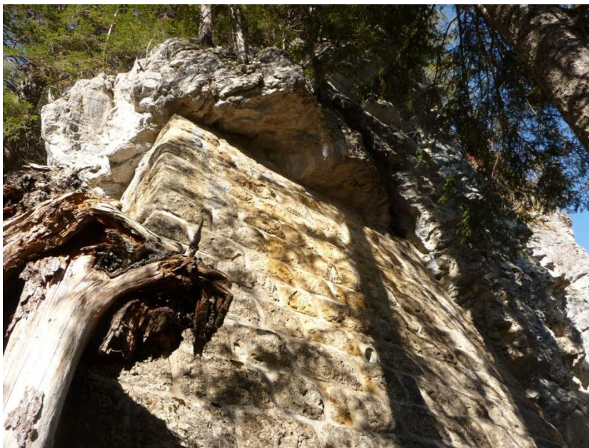
Abbildung 13: Taubeufels-/schopf - Felsunterfangung ober der Forststrasse
