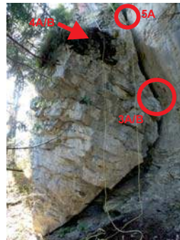
Foto: Übersicht Messstellen 3 + 5
