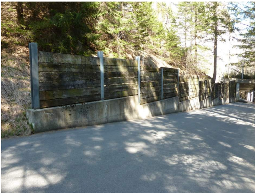
Abbildung 17: Under der Flue - Barrage neben Stiegelschwandstrasse
