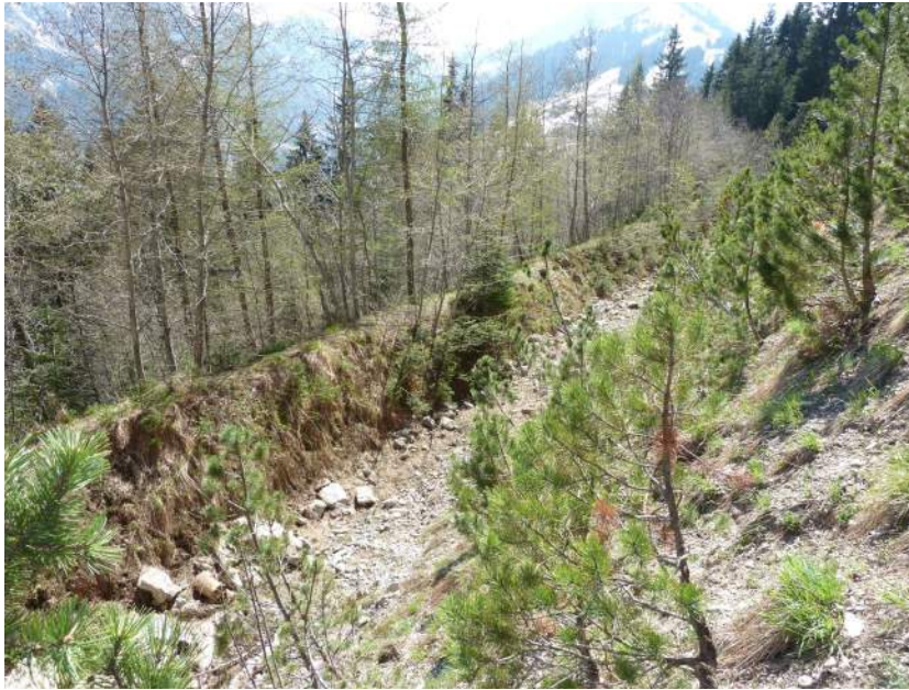
Abbildung 16: Under der Flue - Damm
