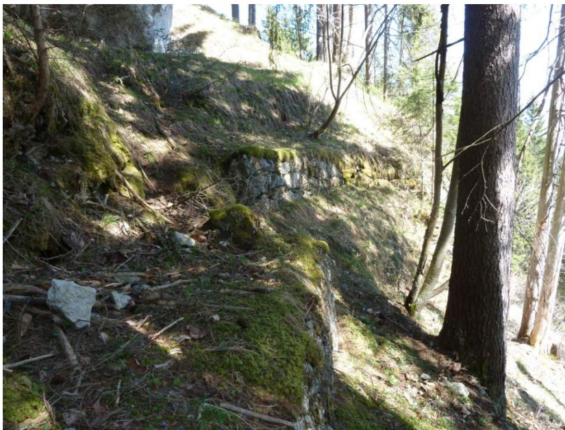
Abbildung 15: Taubenfels/-schopf - Mauer aus Drahtsteinkörben
