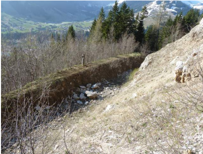
Abbildung 10: Erikafluh - Schwendli: Hauptdamm oben
