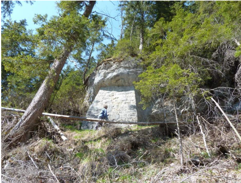
Abbildung 14: Taubenfels/-schopf - Felsunterfangung unter der Forststrasse
