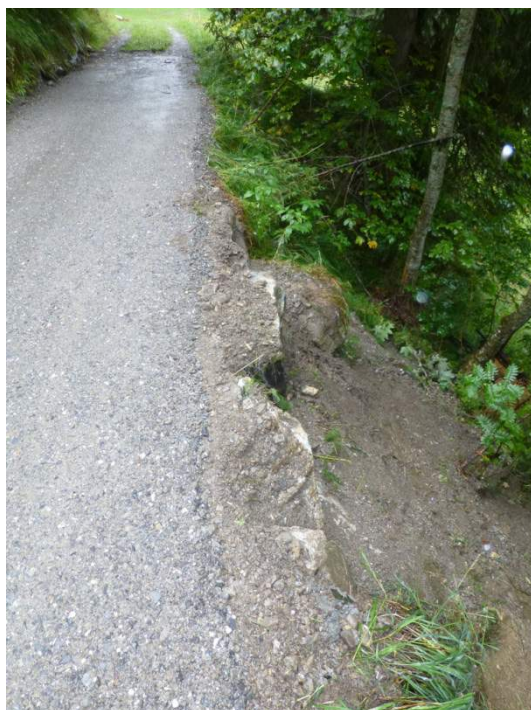
Abbildung 6: Der reparierte Zufahrtsweg zu den Werken VI
