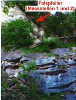
Foto: Übersicht Felsturm Messstellen 1 und 2
