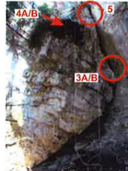
Foto: Übersicht Messstellen 3, 4 + 5
