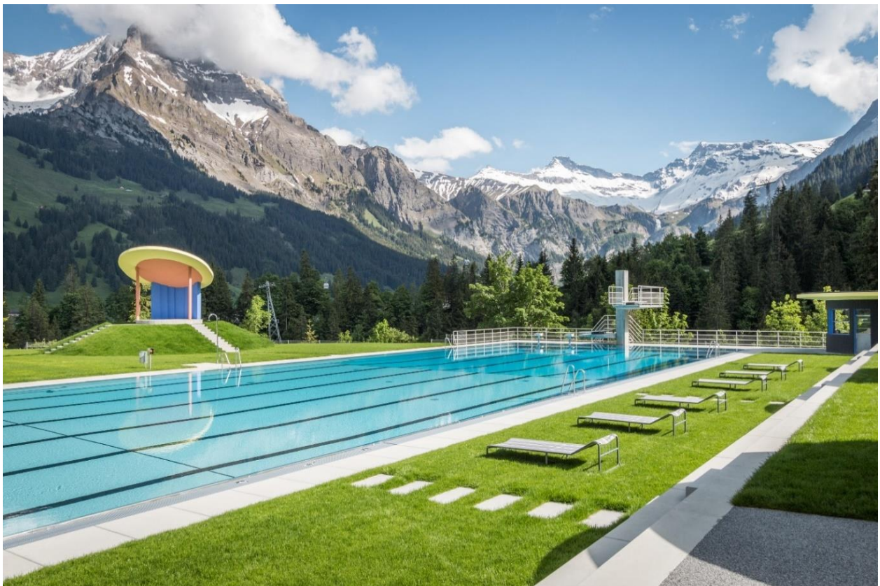
Bild: das sanierte Schwimmbad Gruebi
